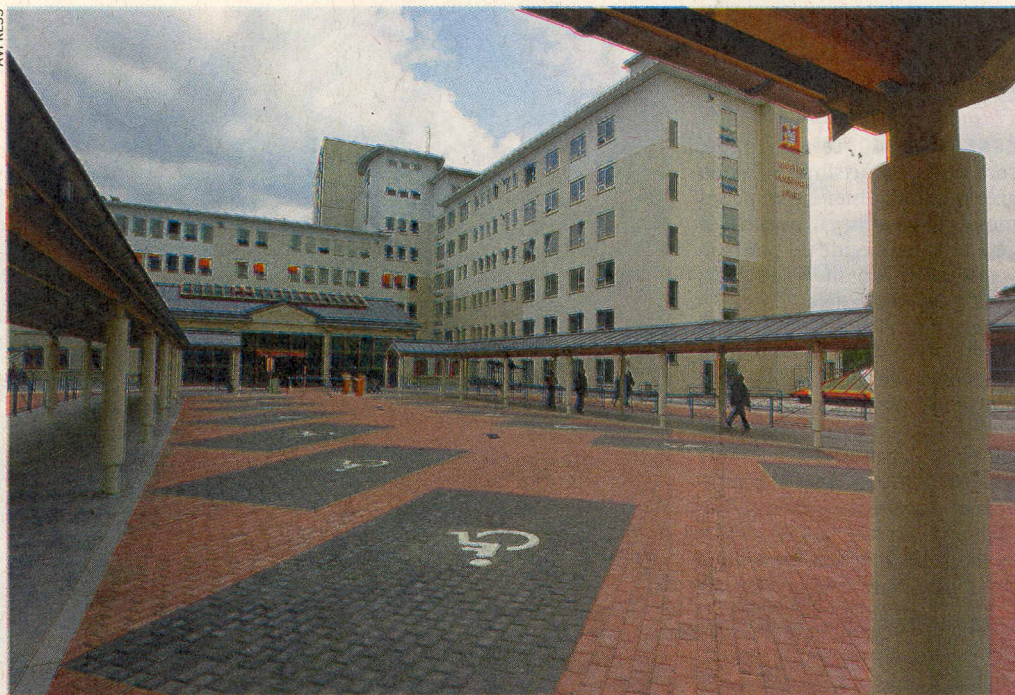
L'hôpital grandit. Avec la fusion avec le Chêne aux Haies, puis au propre avec de nouveaux travaux programmés.
